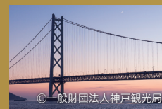
明石海峡大橋
