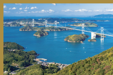
来島海峡大橋
